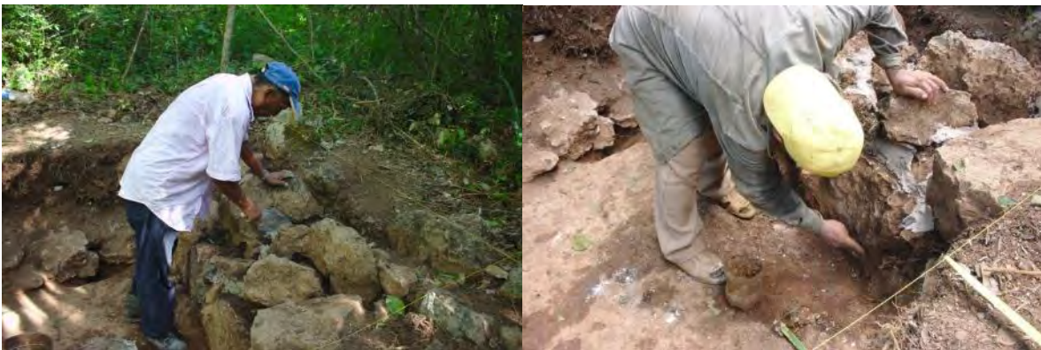
Figura 176. Yo'okop, Operación 20, Consolidación
